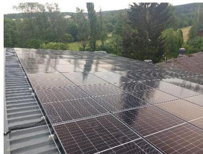
70 Module 450 Watt JaSolar Black Glas/Glas bifazial, 19.2 kWh SunGrow Speicher. Gesamtleistung 30,45 kWpeak Inklusive komplett neuen Zählerschrank und HAK Anschluss. Notstrom.
